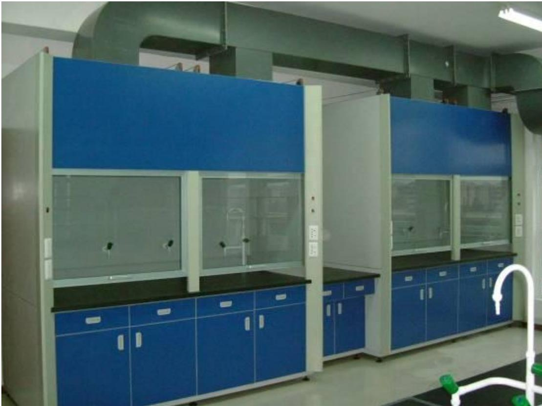
点评: 电源插座在左右两侧, 避免了与实验台水接触。
